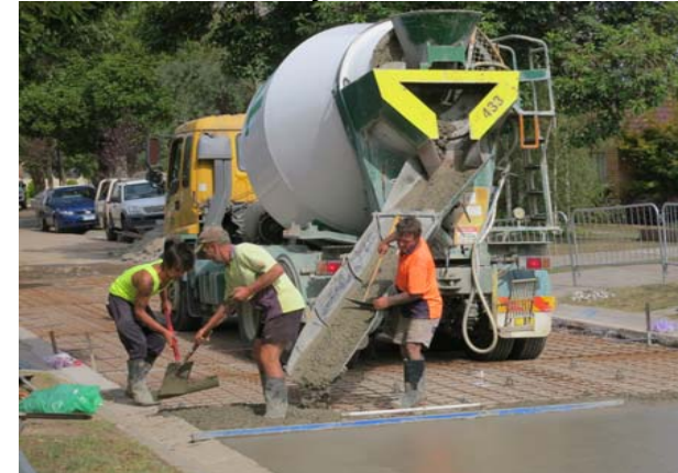
Pouring the new surface
